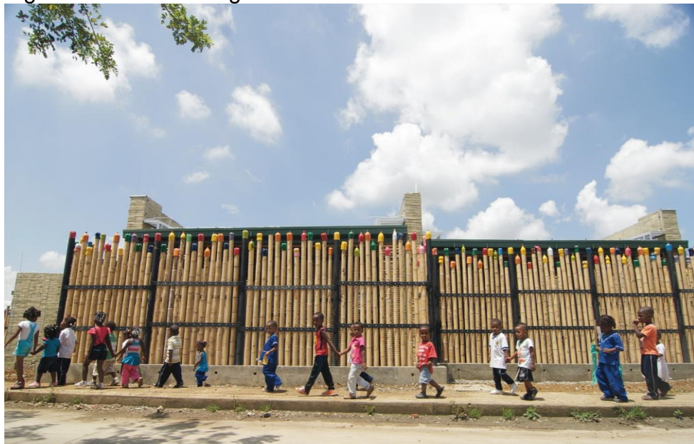
Figura 11 - Muro com garrafas recicladas
