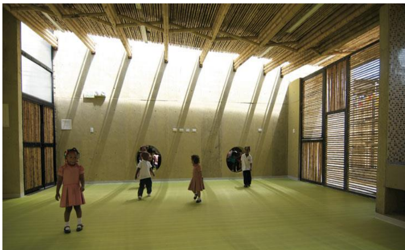
Figura 9 - Fechamento com bambus em algumas paredes
